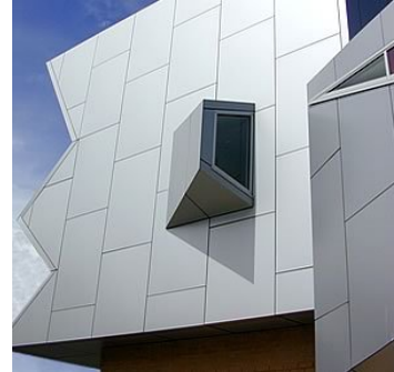
ب منظور وقطاع أفقي لعناصر "Cladding" قطاعات صلب وألمنيوم- تجاليد معدنية وخشبية وبلاستيكية داخلية وخارجية- زجاج
