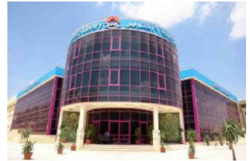
شكل رقم (٧) المبنى الإداري لجامعة ٦ أكتوبر مدينة ٦ أكتوبر- الجيزة
